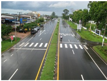
ムクタホンコンカムソイ区間 (国道 212 号)
