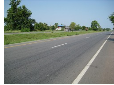
バンパイイーボラブエ区間 (国道 23 号)
