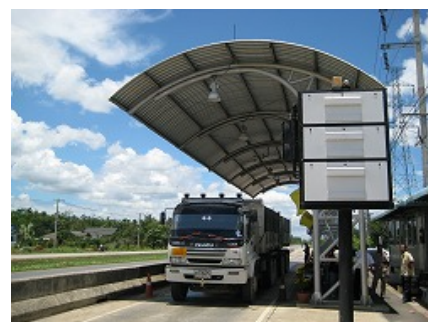
国道 401 号線のドンサック・ジャンクシジョンに設置されている計量場
