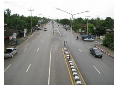
ナコンシータマラートー国道 41 号ジャンク ション (国道 403 号)
