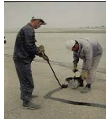
写真1：ビトメンによる補修作業の様子
