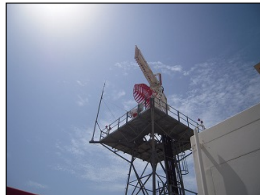
ウルゲンチ空港レーダー
