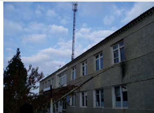
ブハラ・テレコム管内の基幹伝送路中継所
