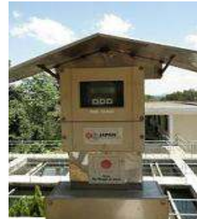
浄水場電磁式流入流量計
