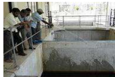
マリンバダ浄水場ろ過池
