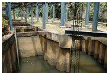
カドゥワ取水場取水路 (左：既設、右：増設)
