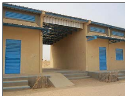
写真2 MCCにより建設された校舎
