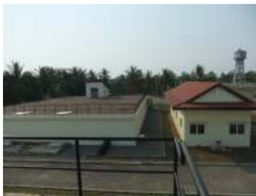
浄水池(左)、配水ポンプ棟(右)、高架水槽(右奥)
