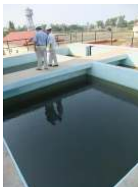
着水井上流部
