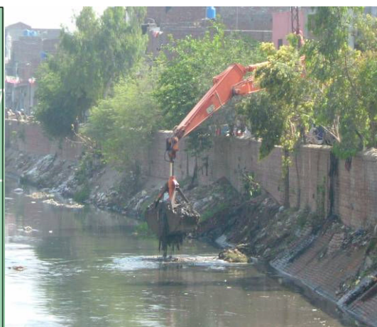
排水路の清掃風景
