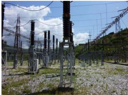
図 2 変電所内 220kV 断路器
