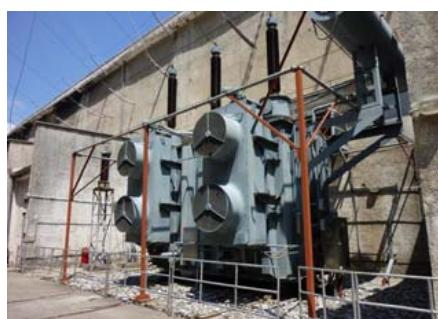
図9 昇圧変圧器<sup>23</sup>
