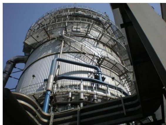
図 12：排煙脱硫装置
