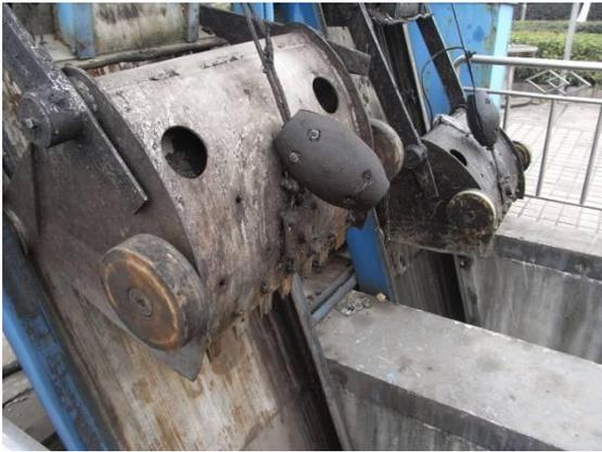
図 2 1-6)長沙開発区下水汚染対策：粗目スクリーン
