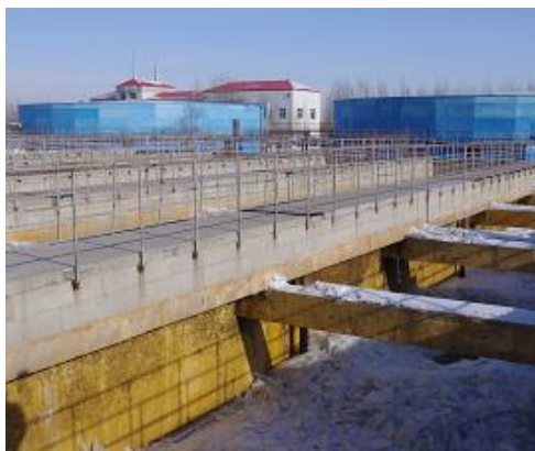
図 2 1-3.大慶汚水処理場
