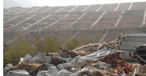
図 9 4-2)長沙市ゴミ衛生埋め立て処分場建設：ゴミ埋め立て処分場側溝
