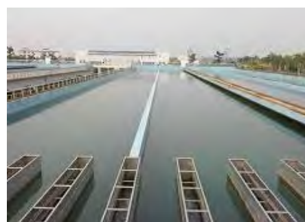
南寧市三津浄水場沈殿池
