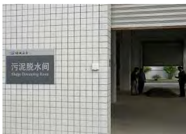
同浄水場の汚泥処理施設
