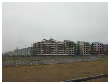
桂林市八里街経済技術開発区 (手前が浄水場敷地)
