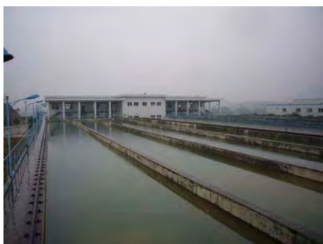
南康（第2浄水場）沈殿池
