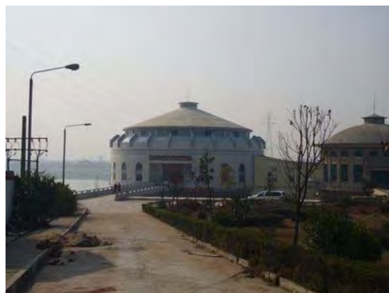
第8浄水場 取水施設
