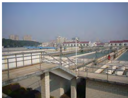
第8浄水場 沈殿地
