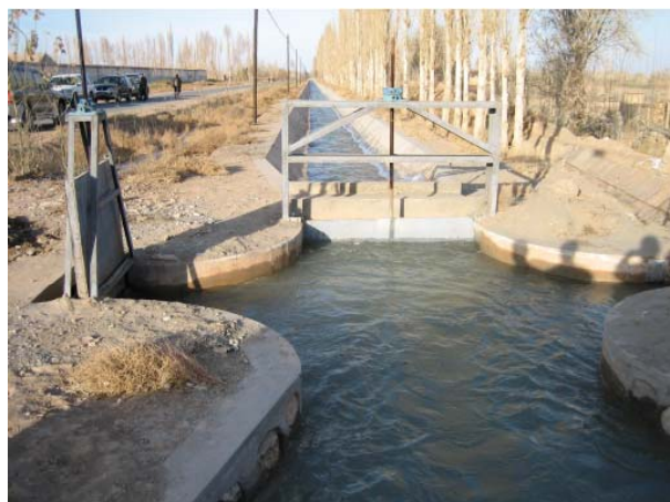
完成したコンクリート・ライニング水路
