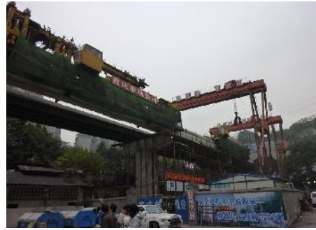
図7 建設中のモノレール3号線
