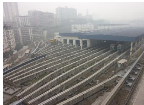
図3 車両基地（大堰村駅に隣接）
