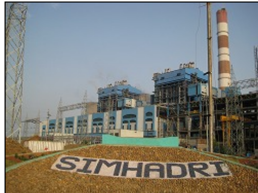
シマドリ火力発電所
