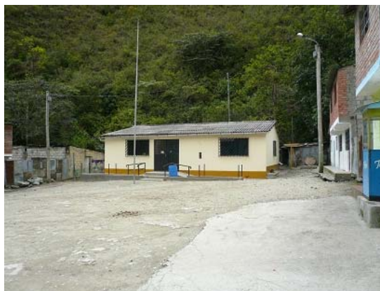
移転先に建設された診療所
