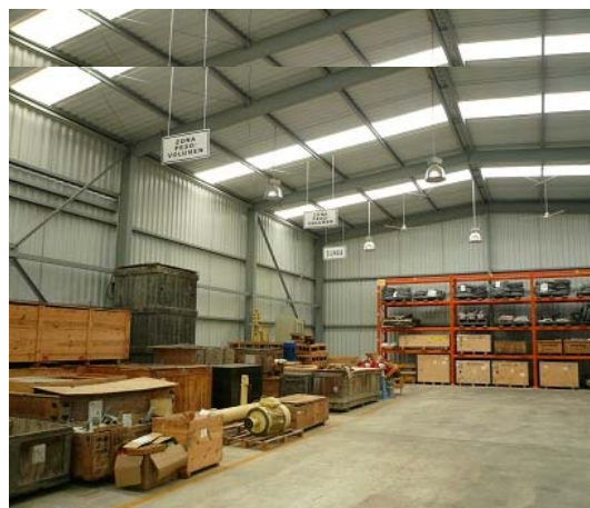
変電所敷地内の予備部品倉庫
