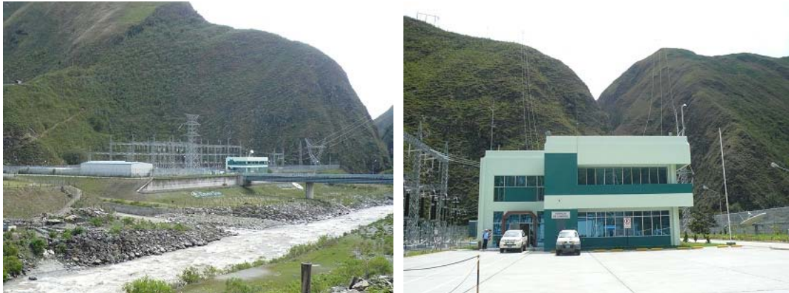
サンタイザベル変電所と事務棟
