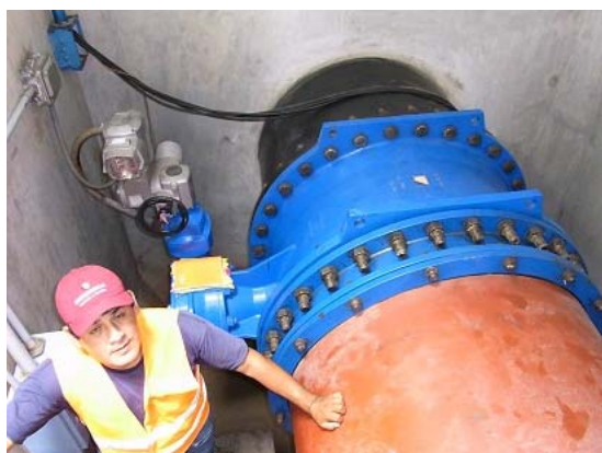
送水管と既存下水管の接続部
