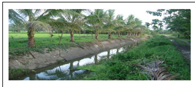
灌漑事業で建設された基幹用水路
