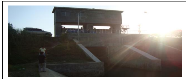
洪水制御事業で建設された洪水樋門
