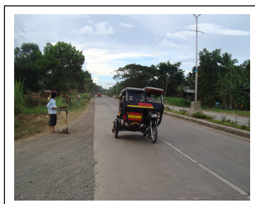
4車線に拡大された道路
