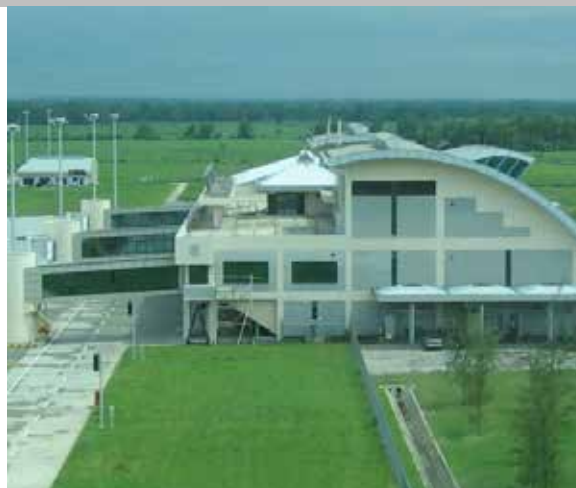
本事業により整備された旅客ターミナル (新バコロド空港)
