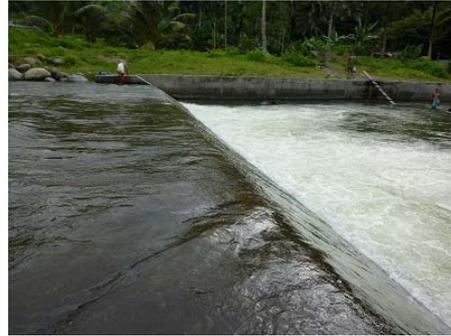
図10 堆砂防止のための練石積工
