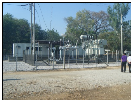
写真2：仮設変電所
