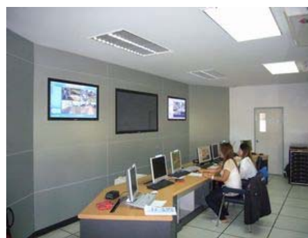
交通管理モニタリングルーム （現場事務所内）
