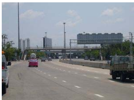
南北道路 北端ラム 3 世道路との接続時点
