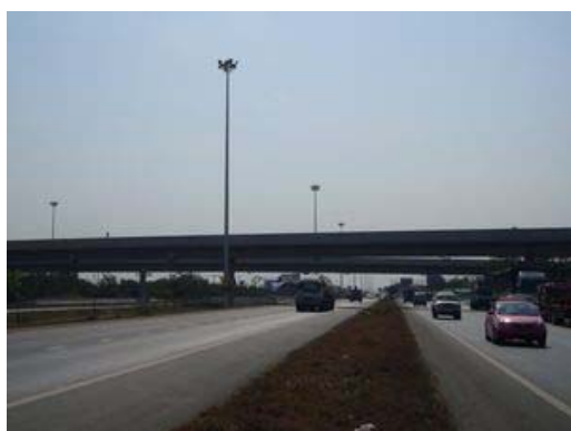
南北道路—345 号線交差点
