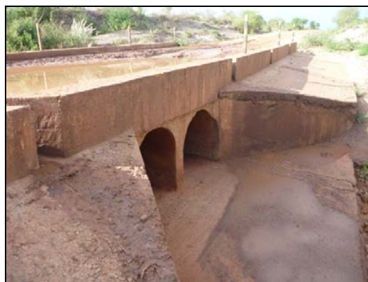
写真2：沈下橋（ドリフト）
