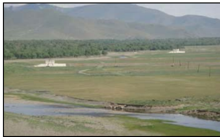
トーラ川沿いの取水井戸(全16井)
