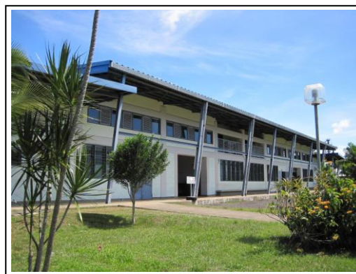
本事業で整備した工学部棟
