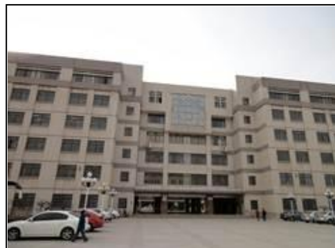
本事業で建設された校舎(西安理工大学)
