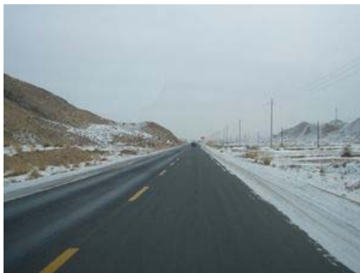
景泰－西槽道路 丘陵部
