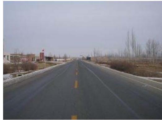
景泰—西槽道路 始点地点（西槽）
