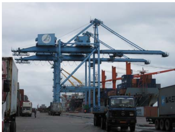
稼働中のガントリークレーン
