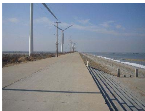
萊州市防潮堤（改修工事）
