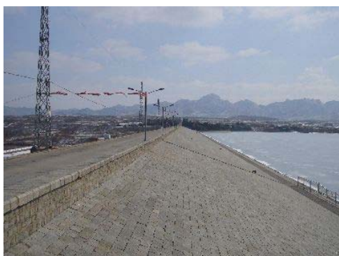
龍口市王屋ダム（改修工事）
