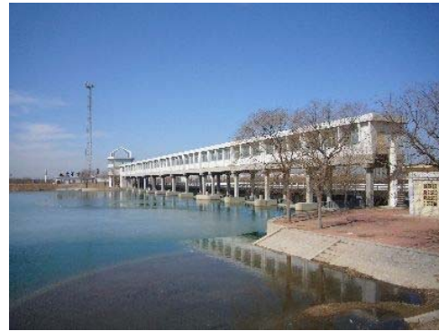
菜州市地下ダム（新設工事）
