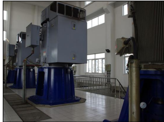
図 7 取水ポンプ場
