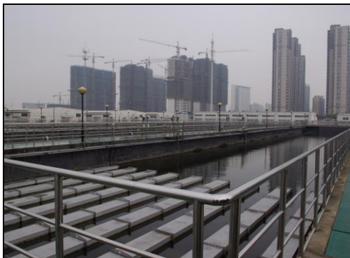
図 4 福星処理場 生物反応池
