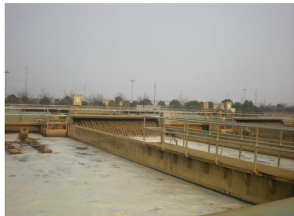
図3 酸化溝（嘉興市汚水処理場）
