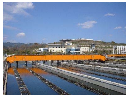
第7浄水場（沈殿池及び事務所棟）
