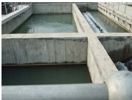
浄水施設（プラントC）
