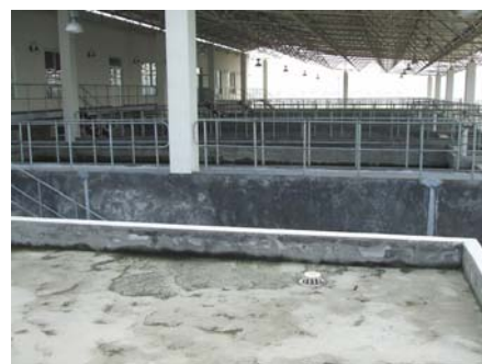
浄水施設（プラントC）
