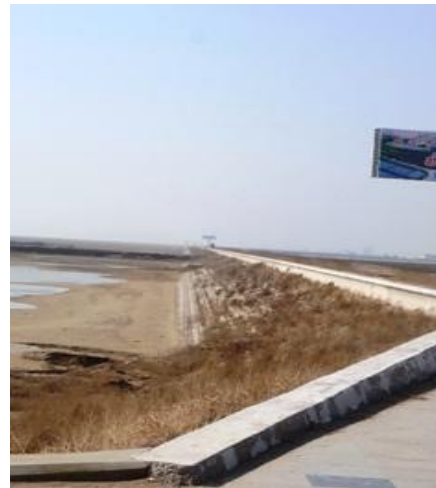
図3 下鎮地区の堤防
