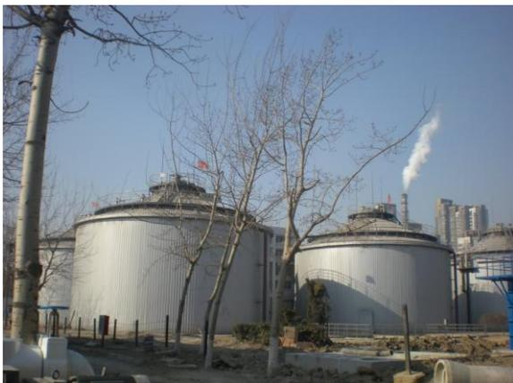
図 13 汚泥消化槽<sup>32</sup>（紀庄子污水处理場）
