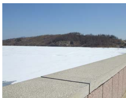
庄河上水の取水地 朱隈ダム
