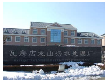
瓦房店污水处理厂
