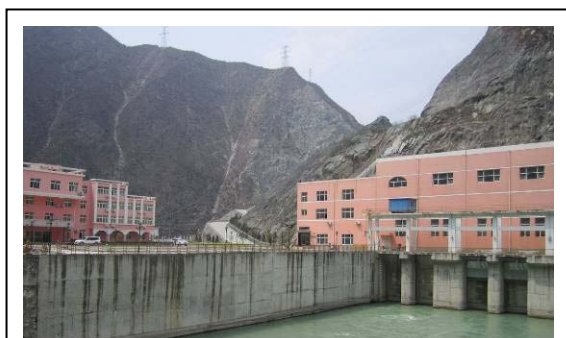
(漢坪咀発電所のタービン建屋[右側建物])
