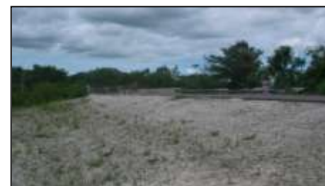
写真-18 補強工事を行った道路
