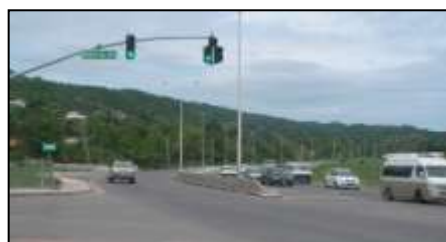
写真-5 4車線化された道路の状況
