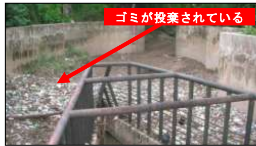
写真-12 山側上流の流入口
