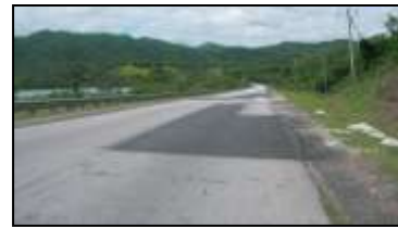
写真-9 道路修繕の状況
