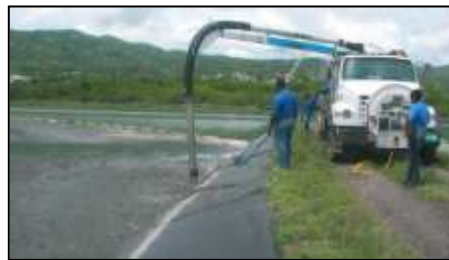
写真-16 廃水安定池の清掃
