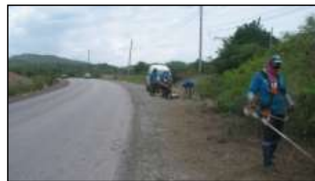
写真-17 道路清掃の様子
