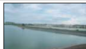
排水安定化池
