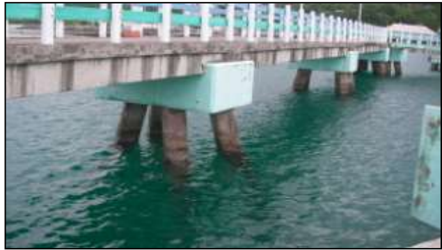
写真-21 杭の状況
