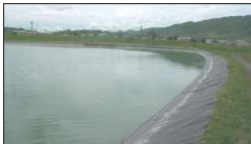
写真-2 処理施設の状況(処理用沈殿池)
