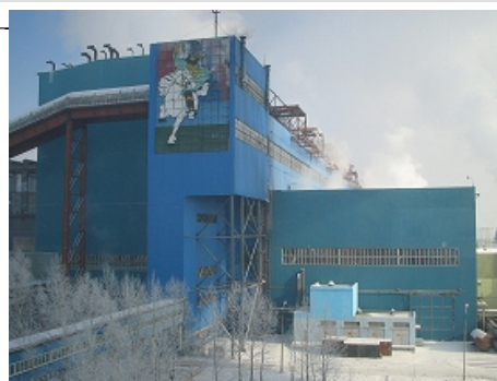
(ウランバートル第4火力発電所)
