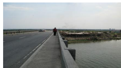
本事業で建設された橋梁
