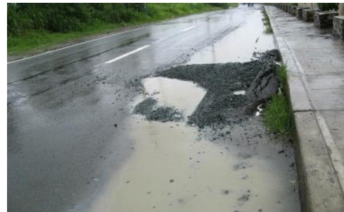
図3 本事業で建設された管理用道路
