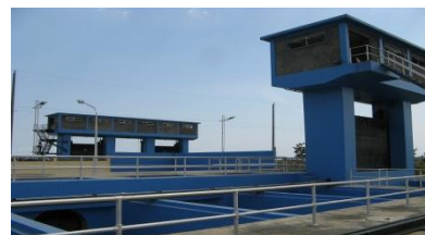
本事業で建設された排水機場
