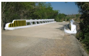
図 7 建設された農道－橋梁
