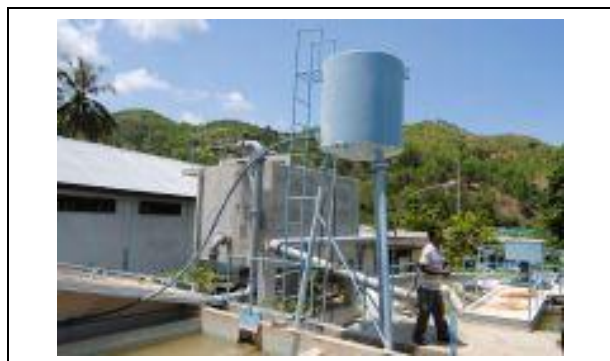
ラハネ浄水場の全景
