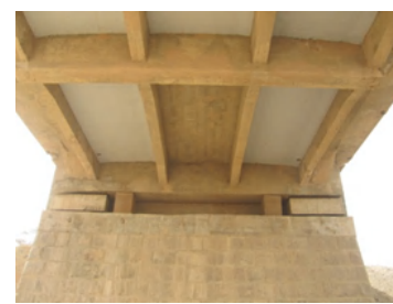
エムクル橋（補修）支承
