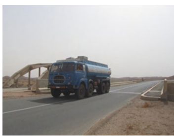
ドガリ第2橋（新設）（奥が旧橋）
