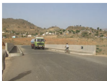
ギンダ橋（新設）とバイパス道路
