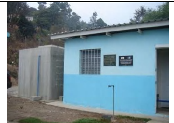
ポンプステーションと貯水槽(チマルテナンゴ県)
