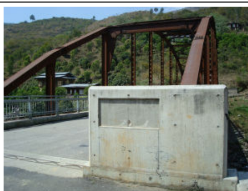
タンマチュー橋の銘板設置場所
